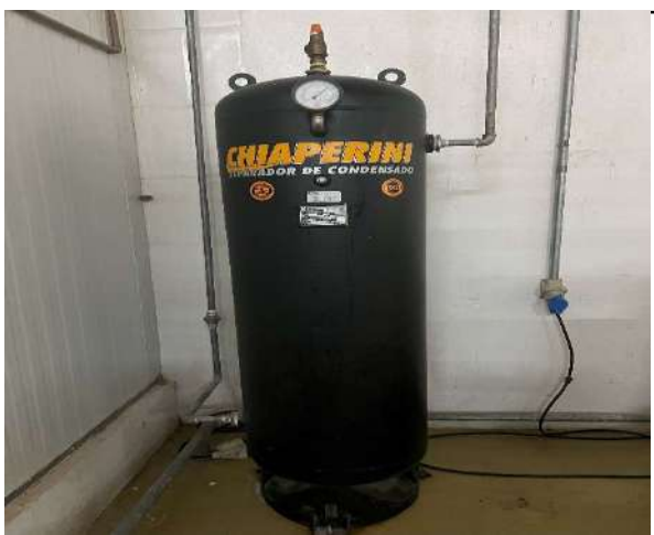
Panetones: Tanque Pulmão Ar Comprimido
