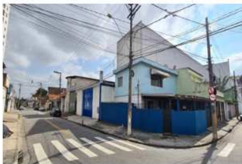
Vista da Fachada Rua Lauro Muller
